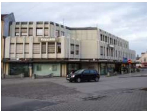
Oversiktsbilde (tatt fra hjørnet på andre siden av veien)
